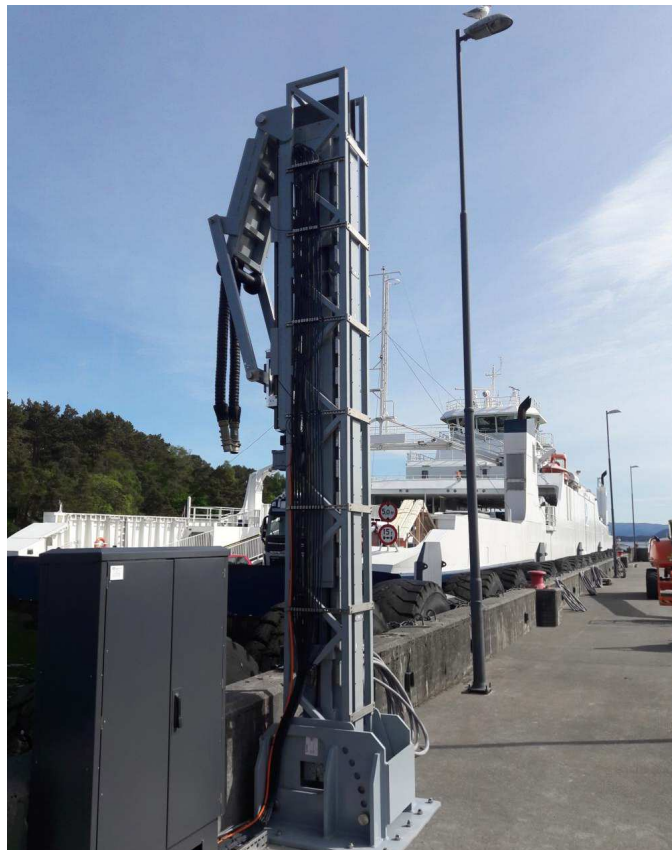
写真：イグスの「エナジーチェーンディスペンサー」陸電供給システム
